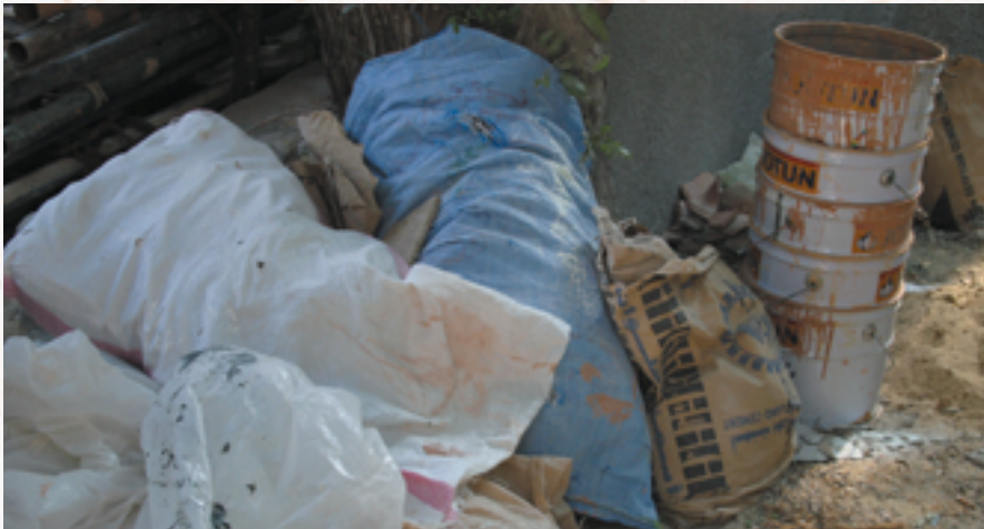
مواد إعادة بناء متولدة عن احدى الشقق تم التخلص منها.
