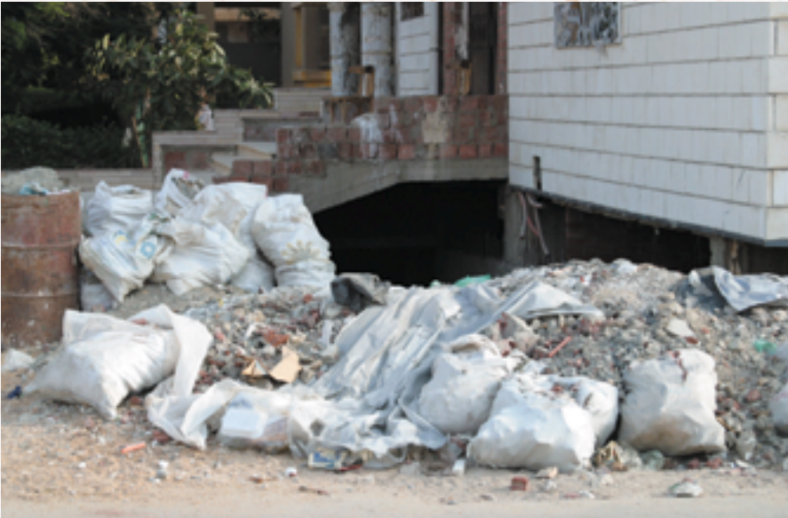
مخلفات بناء وهدم غير موضوعة في حاوية بجانب مبنى جديد الإنشاء.
