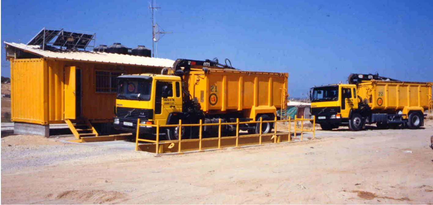
محطة وزن بالطاقة الشمسية فى مدفن غزة - دير البلح (الصورة مان فيرد شوجي فى ٢٥)
