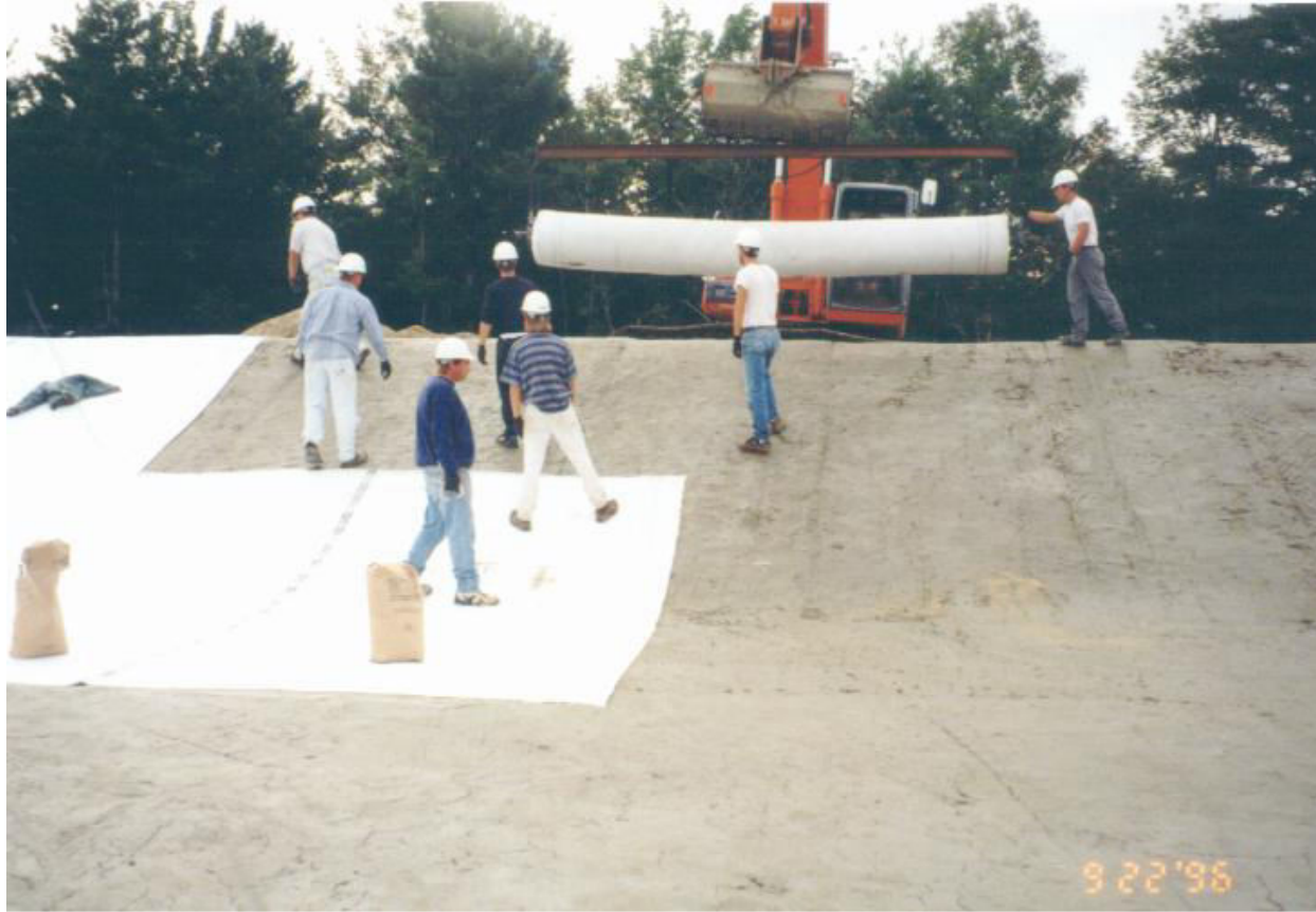
تركيب طبقة النسيج النفاذ
