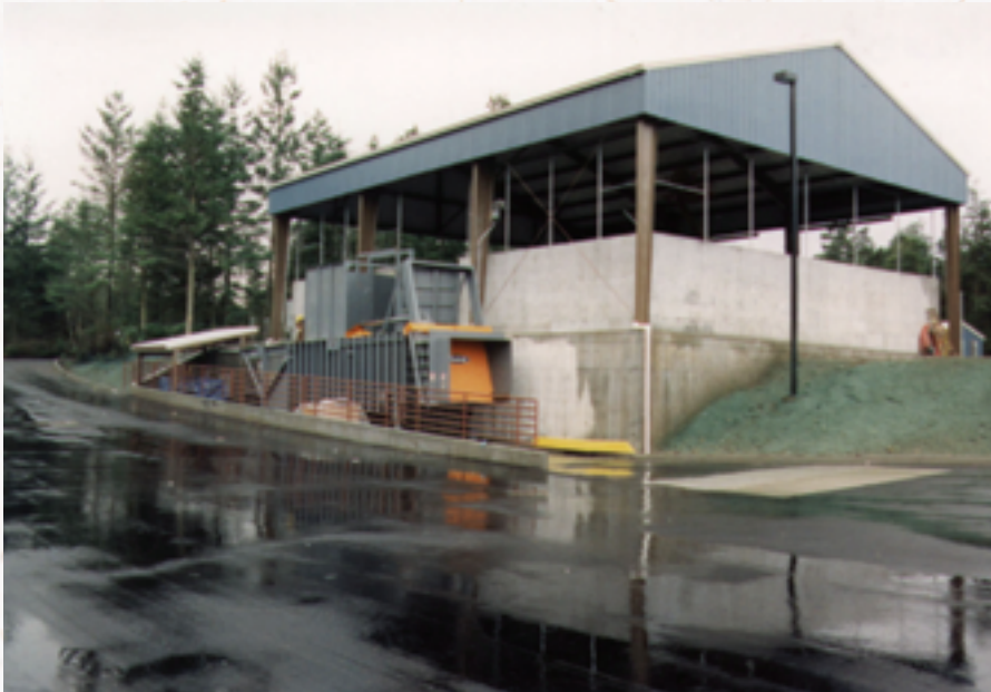
وحدة دك المخلفات داخل محطة النقل الوسيط
