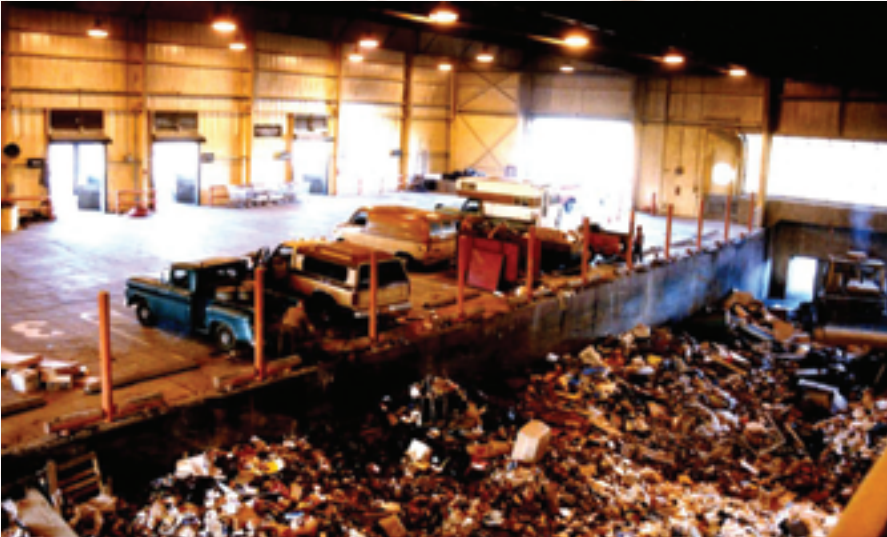
حفر لتلقي وتخزين المخلفات داخل محطة كبرى للنقل الوسيط
